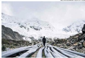
Solución provisional. Se ha instalado un sistema de sifones para disminuir el volumen de la laguna Palcacocha, pero el riesgo de inundación sigue.
